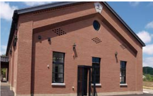
ミュージアム工場「啓匠館」。外観の煉瓦は、一つ一つが煉瓦積み職人による手積み。内部の壁面は、左官職人によって漆喰塗りで仕上げられていて、建物からも職人の息吹を感じることができる。
