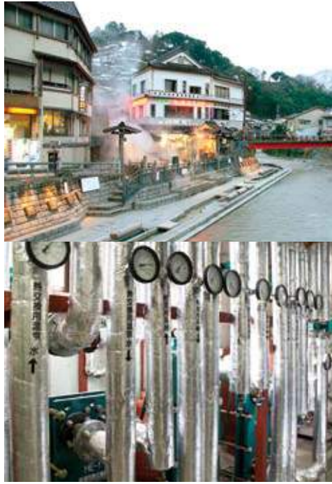
(上) 湯けむりが立ちのぼる源泉「荒湯」の風景。周辺では足湯や温泉玉子が楽しめる。(下) 公衆浴場の「薬師湯」では、高熱泉を利用して、冷暖房や床暖房、シャワーなど、様々な用途で温泉を有効利用している。
