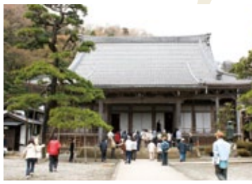
浄土真宗本願寺派の一乗山照満寺。西本願寺が火災の際に、一番乗りに乗ったことから、一乗山の山号が名付けられたと伝わる。大正12年の建立で、北但大震災の被災もまぬがれた立派な建物である。
