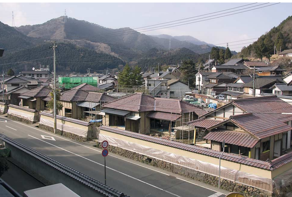
改修工事が進む旧生野鉱山官舎(甲住宅)。写真手前の2棟は、復原された生野瓦が使用されている。昔は手作りだったこともあり、ひとつとして同じ瓦はないのだとか。品質の安定が求められる現代において、いかに不揃いに造るかで試行錯誤したという。生野瓦独特のまだら模様がとても忠実に復原されている。古い瓦と比べても、遜色はないでさばえ。
