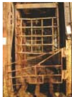
1分間に300メートルの速さで地下を行き来した人形立坑(たいじゅうたてこう)。
