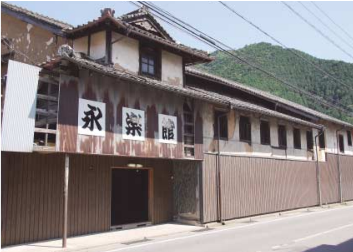
復原前の永楽館。
