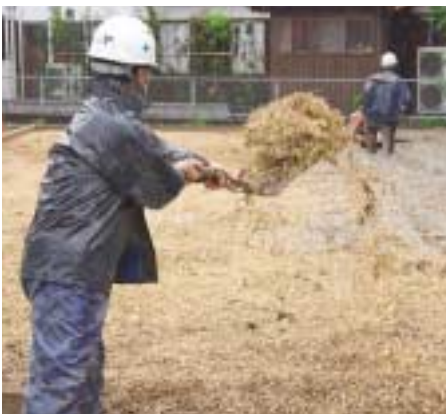
はがしとった古い土と新しい土が混ぜ合わされた壁土。ワラスサを混ぜた後、音ながらに半年以上かけて練り合わされた。
