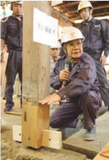
工事見学会で様子の説明をする田中棟梁。
