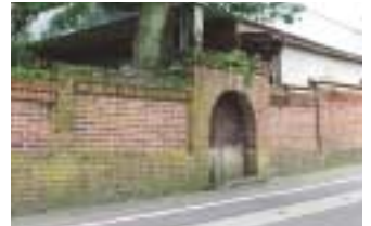
西光寺の煉瓦の積み方は上部が長手積み、下部がフランス積みとなっている。
