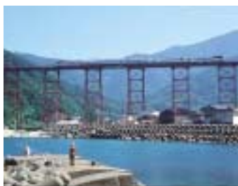
日本海の潮風に耐え続けてきた余部鉄橋
