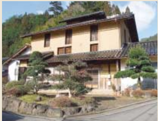
風情のある土壁に越屋根が印象的な「中3階建て養蚕住宅」。蚕の飼育面積を確保するため、3階部分が付け足された。リズム感のある窓の配置や、切り妻屋根とひざしのシンプルなラインは、ノスタルジックな付まいを醸し出している。
