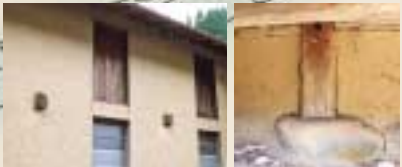
(左) 2階部分から突き出るかつての屋根の梁。(右) 養蚕農家住宅の基礎部分は、石に乗っかっているだけ。
