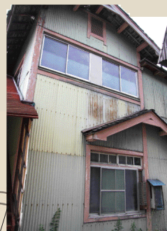
大正時代に建てられた木造校舎の 一部が残っている
