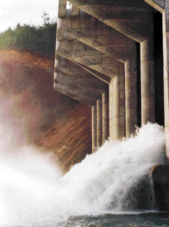
上部の黒川ダムから地下発電機を通して、下部の多々良木ダムへ初めて水がためられる初揚水式の様子
