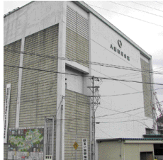
八鹿町民会館
