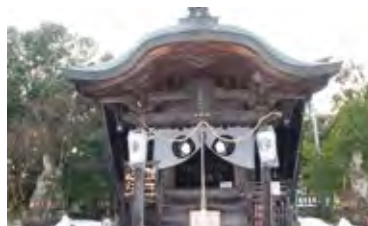
小田井縣神社は式内神社で、国作大己貴（くにつくりおおむち）命を祭神に祀っている。昭和になってから、円山川改修工事で移転や境内の改築が行われ、現在に至っている。
