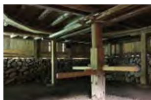
葛畑舞台の特色である「田楽返し」(上)。10枚の襖を90度、180度回転させることで、背景を変えたり、奥の遠見を見せる。「ブドウ棚」(中)は背景を屋根裏に吊り上げる格納庫。地下の奈落(下)から独楽廻しに円型舞台が回転する。
