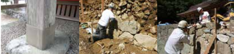
傷んだ部分は根継ぎ(左下)という方法で新しい部材に取り替えられた。できるだけ前の部材と同じようになるように色味なども調整している。崩れた石垣は勾配を確認しながら積み直された。解体前に付けた番号通りに石垣を積み直し、元の姿のままに復元されている。
