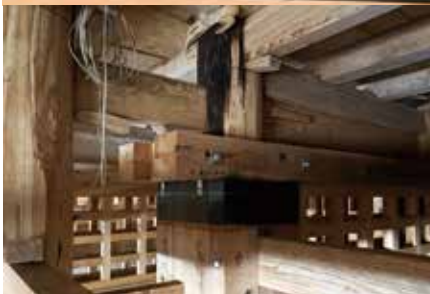
拝殿床下(中央)には耐震のための補強材が取り付けられ、石垣の崩壊や地盤沈下に備えて鉄骨架台が設置された。本殿床下(下)には格子組の耐震壁が設置され、柱周りにも揺れを吸収する耐震補強が施されている。
