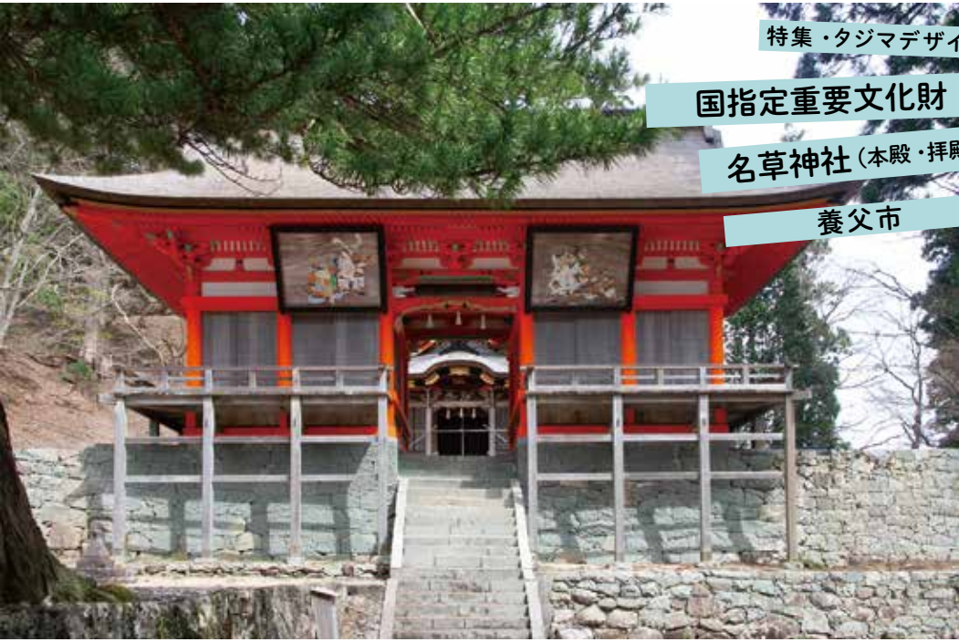
拜殿は割拜殿という珍しい様式で、正面の縁は石垣の前方に張り出して下から支える懸造で建築されている。
