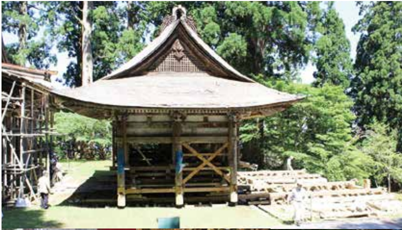
拝殿は曳屋工法(左)で建物を移動し、基礎や石垣を修理した。修理前の発掘調査により、礎石の抜き取り跡が見つかり、古い拝殿は現在よりも1.8m本殿側(北側)に建てられていたことが分かった。現在の拝殿は石垣を積んで、南側に動かしたと考えられている。
