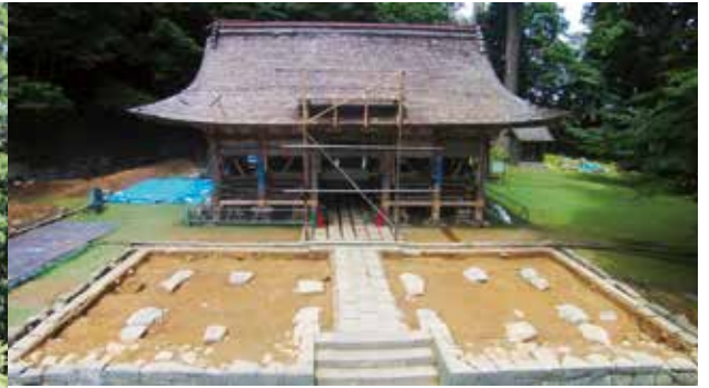
拝殿は曳屋工法(左)で建物を移動し、基礎や石垣を修理した。修理前の発掘調査により、礎石の抜き取り跡が見つかり、古い拝殿は現在よりも1.8m本殿側(北側)に建てられていたことが分かった。現在の拝殿は石垣を積んで、南側に動かしたと考えられている。
