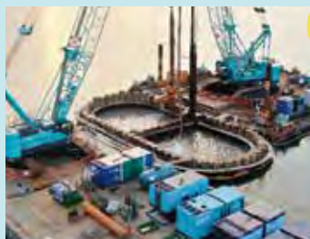
昨年完成した城崎大橋施工風景。ダウンザホールハンマ工法で土台を作っている様子。水中での施工も植物性ロックオイルを使用して環境に配慮している。
