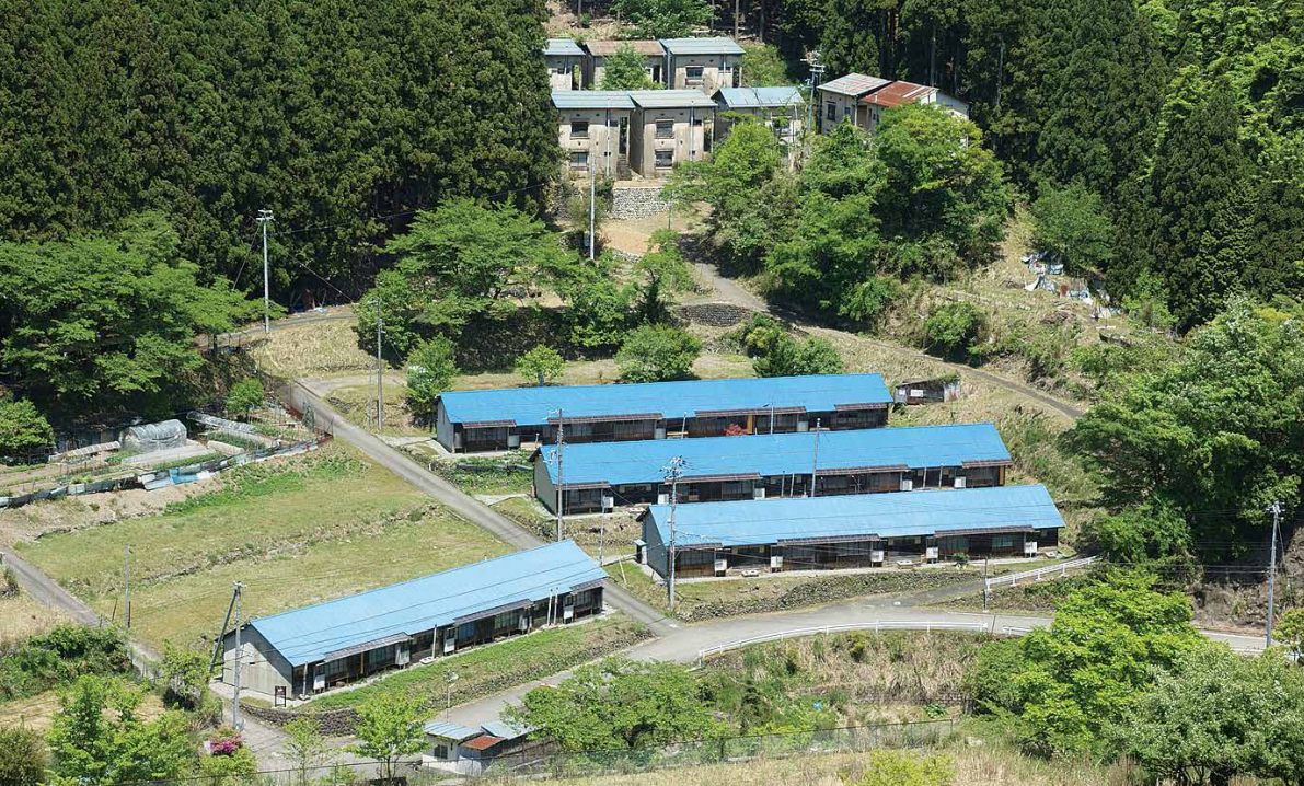
令和6年初夏公開の映画『湖の女たち』のロケ地となった明延鉦山の社宅であった「北星社宅」。昭和8年から昭和13年にかけて建てられた木造の「長屋」と、鉄筋コンクリート製の「プレコン」の社宅を合わせて、「北星社宅」と呼ばれている。最盛期の昭和30年代には明延全体で780戸の社宅があり、4,000人以上の住民が生活した。イベント等で内部を公開。
