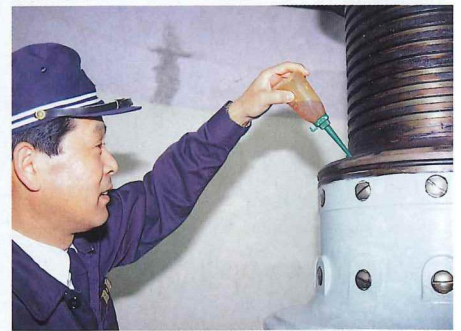
レンズが回転する部分、定期点検を怠りなくやっている。油を差したり、レンズをきれいに磨いたり忙しい。
