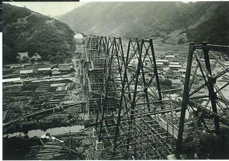
建設が進む当時の写真。橋脚部分が組み立てられています。たくさんの人々と最新の技術によってつくられました。
