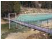
簡易水道を引くために作られた吊り橋。鉱山で使われるケーブルが流用された。
