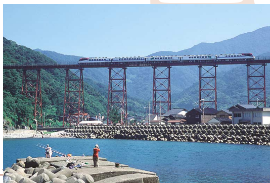
工事着手前の余部橋梁。11本あった橋脚はコンクリート橋では4本となる。
