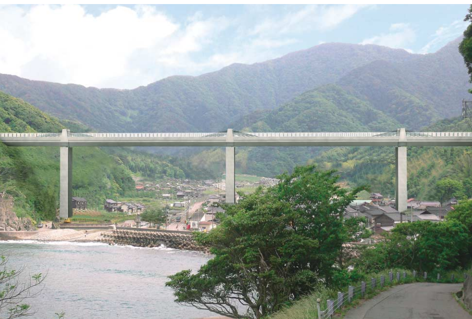
安全性を第一に考えながら、現在の鉄橋のスレンダーな外観を壊さないように設計された新橋の完成イメージ図（JR西日本提供）。来年秋の完成に向けて、工事は順調に進んでいる。
