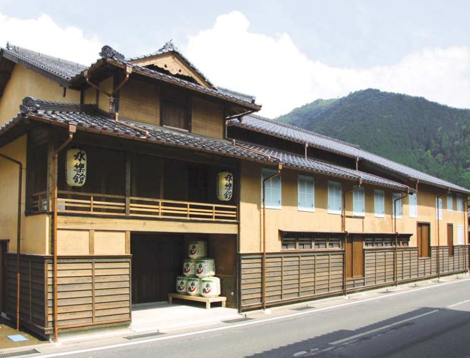
人正11年頃の姿へと忠実に復元された永楽館(左)。明治34年の完成以降、歌舞伎などの芝居興行から映画時代に移り変わるにつれて、幾度となく増改築が繰り返されてきた。復元に当たっては、増改築の工事許可を得るために届け出された図面などを元に痕跡調査が行われた。2階外側の窓枠は、和風建築に似つかわしくない洋風窓が復元されている。これは旧弘道小学校から転用されたものと調査により判明し、当時のまま忠実に水色の窓枠へと復元された。「出石町史」にも「この窓は人変印家的によく目立ち、人々の記憶に残った」と記されている。
