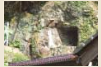
鉱山施設の動力用として、明治9年に築造された送水路跡。旧鉱山本部まで続いていた。
