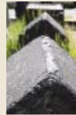
市川河川公園にあるカラミ石。銅などを精錬する際にできるカスを再利用したもの。
