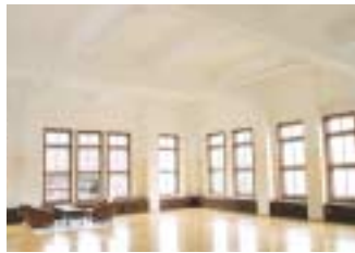
2階ホールの天井の梁。
