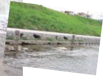
堰には魚道(左)や緩やかな傾斜をつけたり、護岸には巢穴(上)を付けるなど、できるだけ自然に近い改修が行われた。
