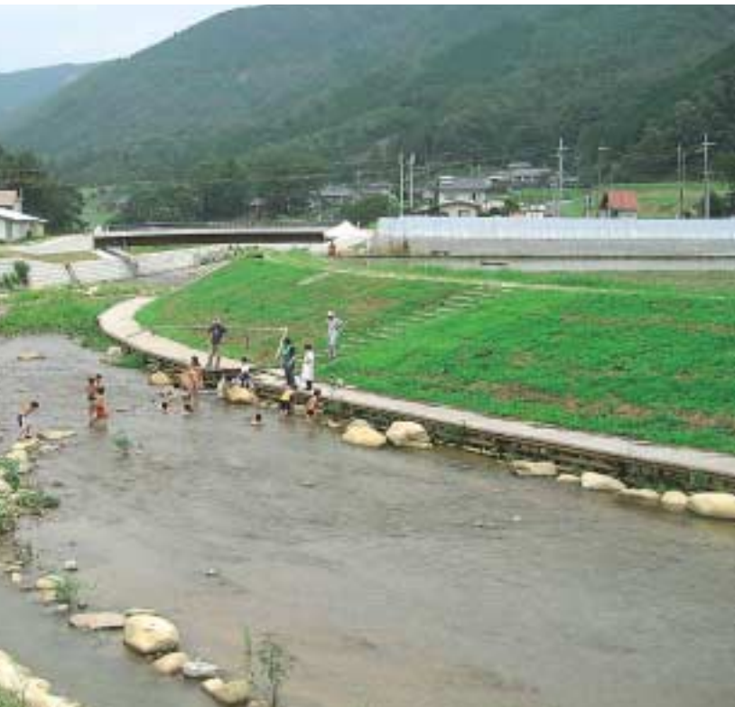
環境に配慮した河川改修が行われた出石川。川を身近に感じてもらえるように階段やボードウォークが設置されている。
