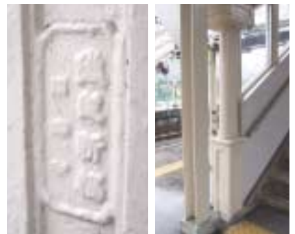
西洋建築を模したデザインが印象的な跨線橋を支える柱。「明四十・鐵道新橋」の銘文が浮かび上がっている。
