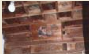
荒霊神社殿の天井に描かれた絵は、南画家・橋本蘭雪の跡である片岡公暉(養父市出身)作ではないといわれている。
