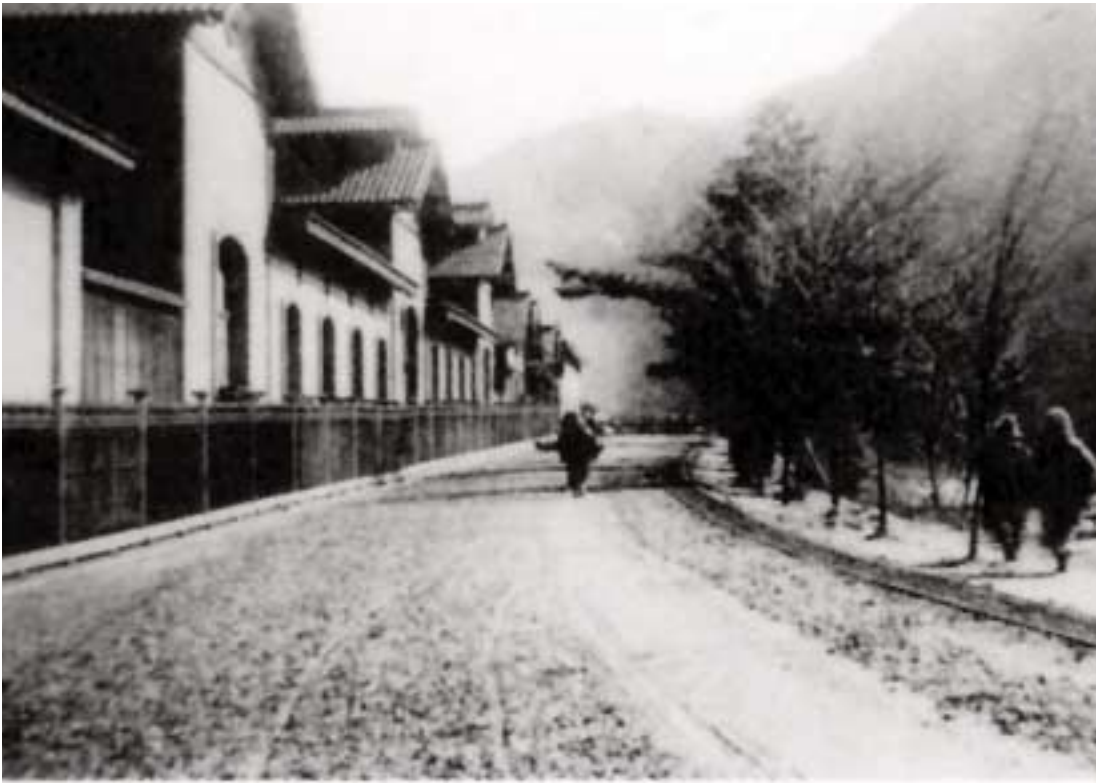
明治時代当時の最新技術が導入された「生野鉱山寮馬車道(銀の馬車道)」
