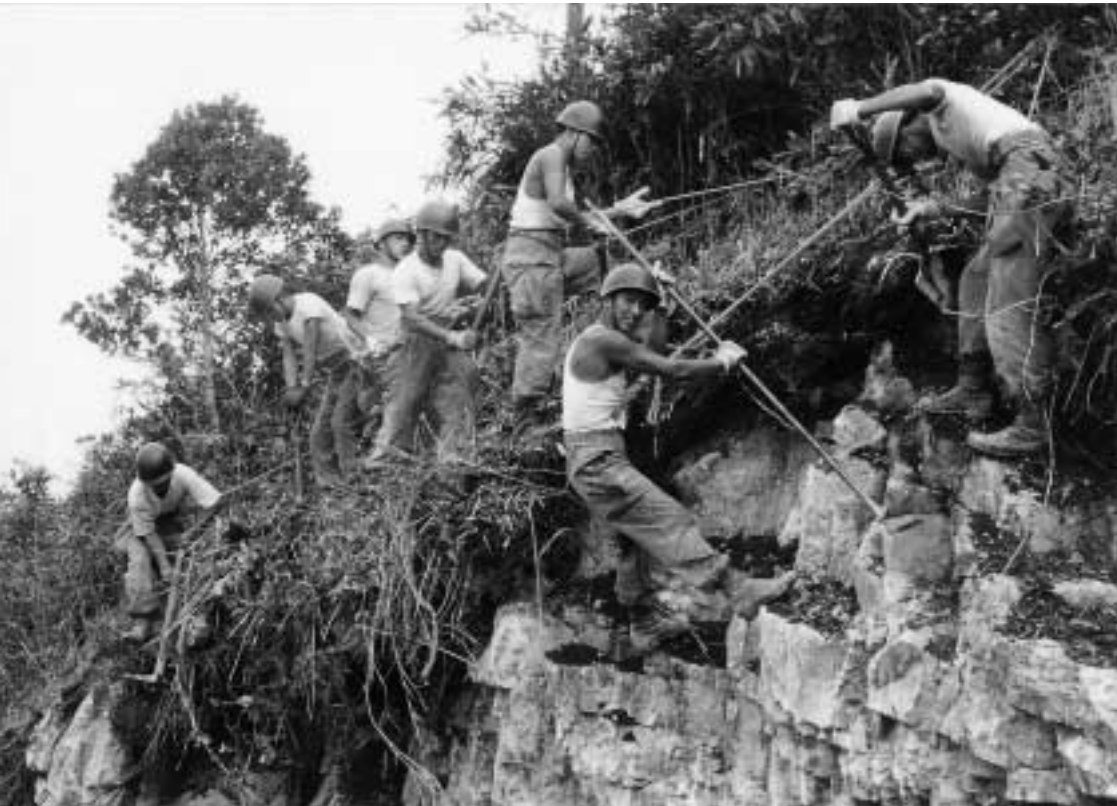
人力で浮石除去作業をする自衛隊員。断崖絶壁での作業は常に危険と隣り合わせだった。(西一氏蔵)
