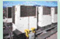
空調システム 「ガスヒーポン(GHP)」
