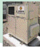
ガスで発電、同時にお湯も使える 「業務用ガスコージェネレーションシステム」
