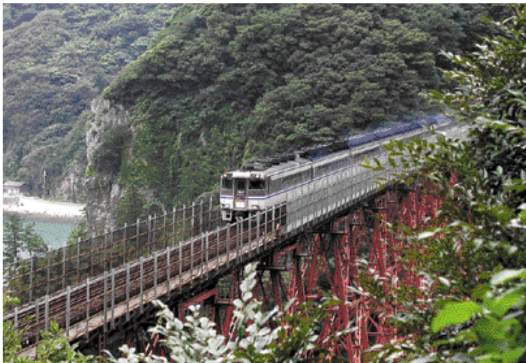
厳しい保守管理の元、 山陰本線の運行が可能になっている
