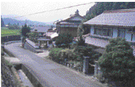
山陰道の通っていた山東町柴、昔は宿場町として栄えた
