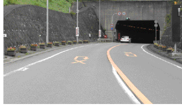
現在の遠阪トンネル
