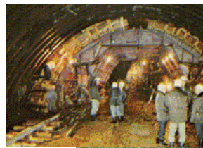
当時のトンネル工事のようす
