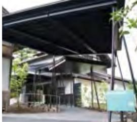
リガレッセのスロープ屋根。現代技術を駆使したシャープな鉄骨と、魅力ある木質屋根が融合している。
