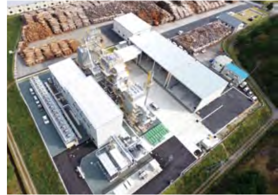
be 材供給センター／朝来バイオマス発電所(朝来市)
